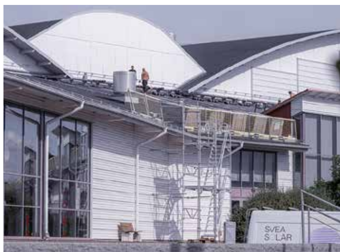
Jönköpings Energi installerar solcellsanläggningen på Elmias tak.
